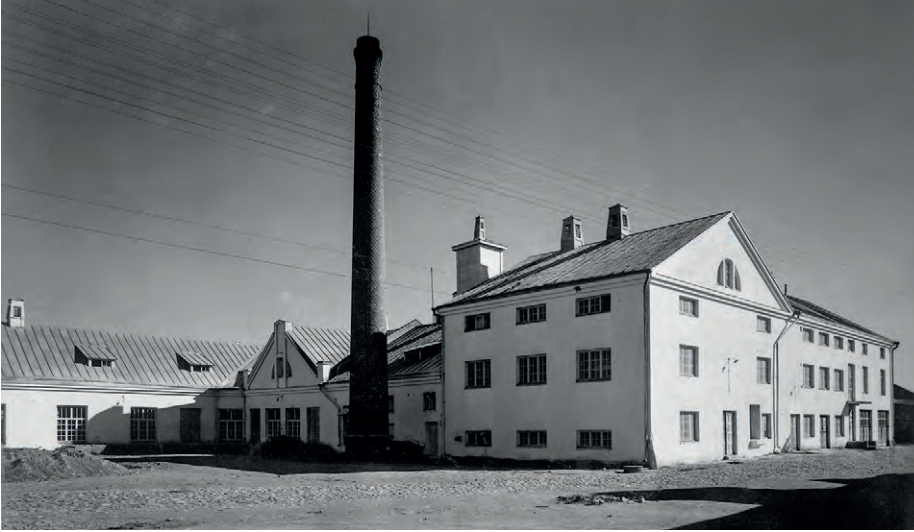
Limingan Osuusmeijeri asennutti omat voimakoneet tilojensa valaisemiseksi. Vuonna 1918 perustettu Limingan Sähköosuuskunta hankki aluksi virtaa sekä meijeristä että Matturin riihestä.
