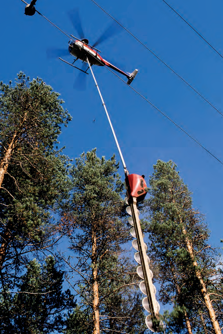
Helikoptereita käytetään apuna sähkölinjojen raivaustöissä.
